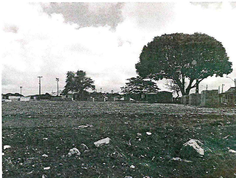
BLOCOS CERÂMICOS NO LOCAL DA OBRA
