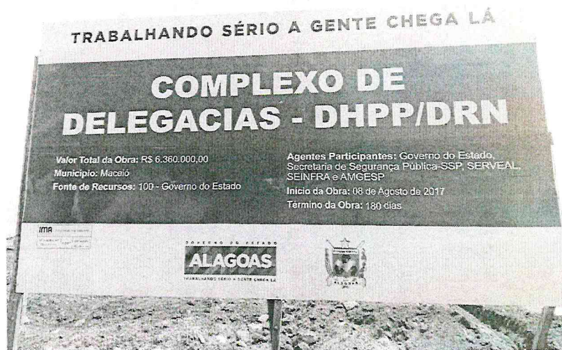
PLACA DA OBRA INSTALADA
