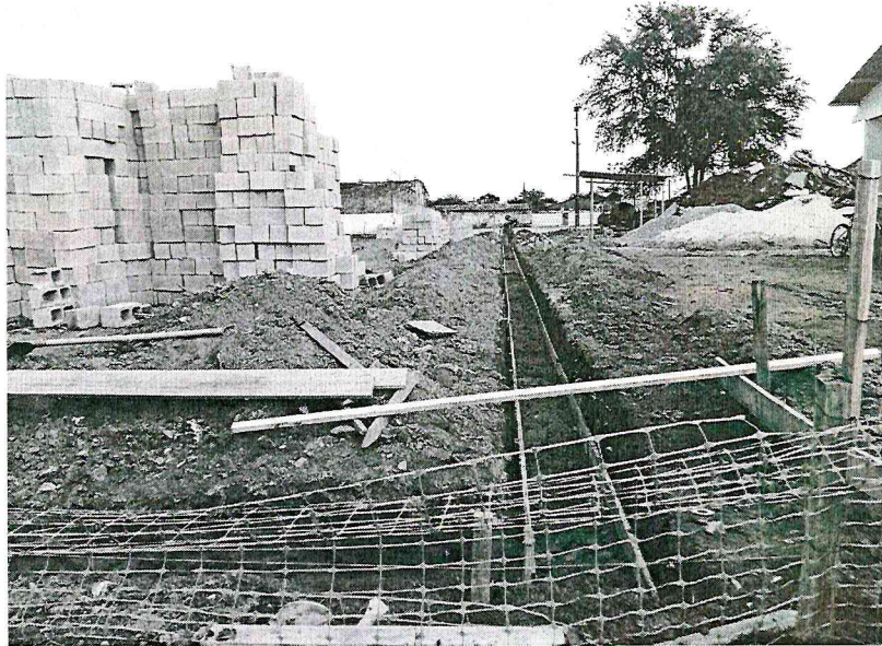
ESCAVAÇÃO DA FUNDAÇÃO DO MURO CONCLUÍDA
