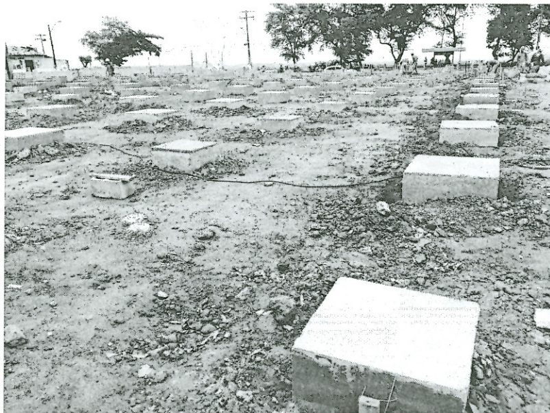
Os blocos de fundação foram concluídos
