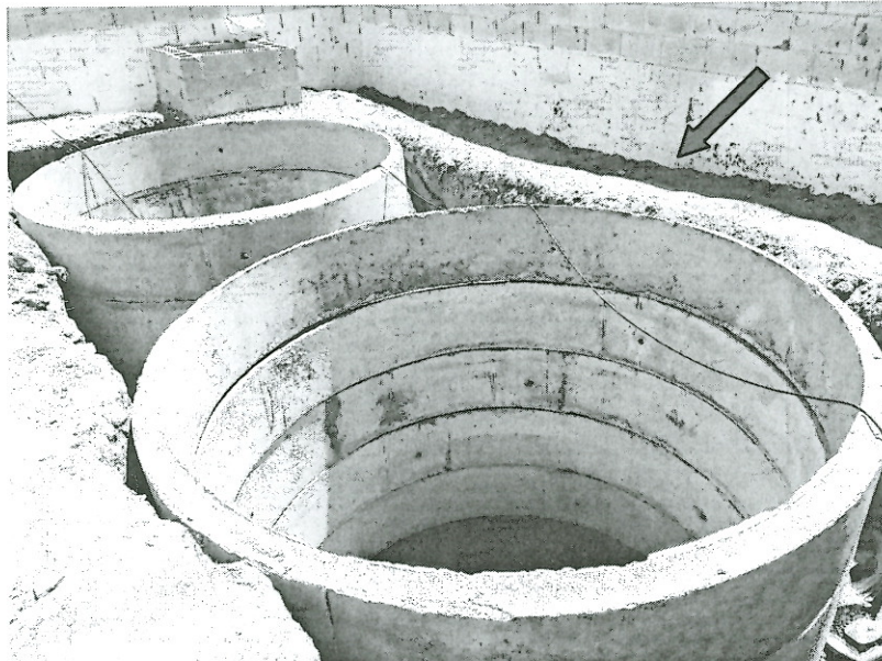
Fossa séptica e poço absorvente sendo executados
