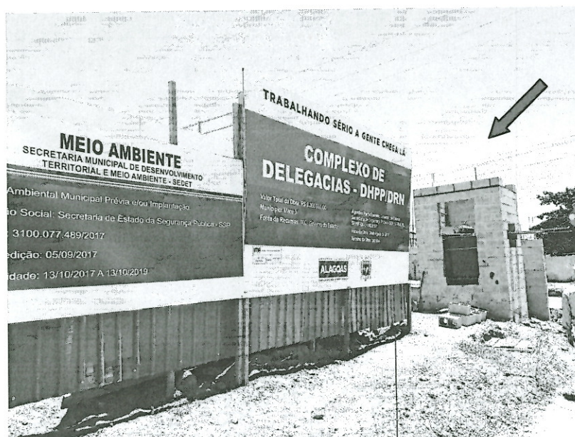
Guarita de segurança sendo executada
