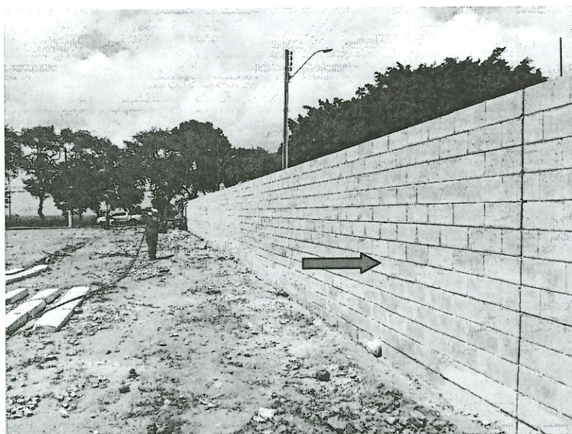
O muro está com 90% do serviço executado
