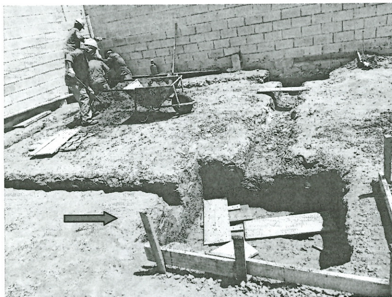
Sapatas de apoio do reservatório superior sendo executadas
