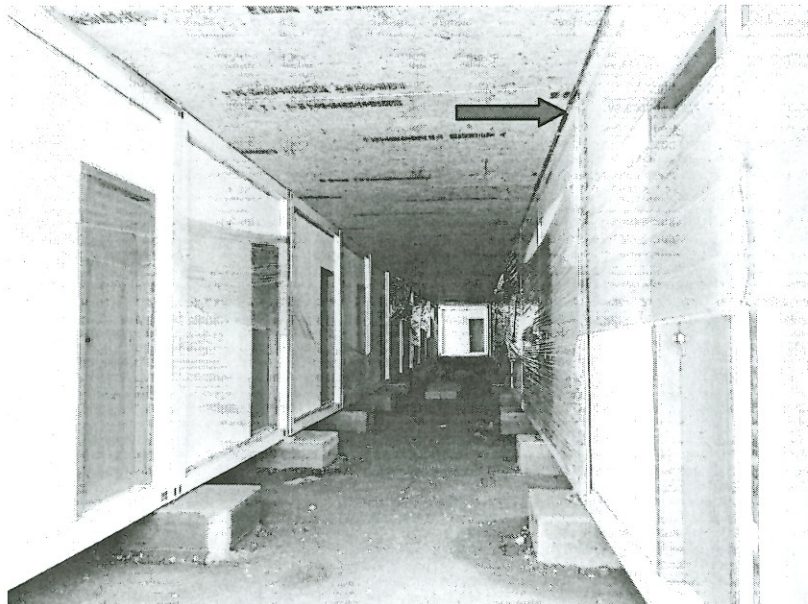
Instalação do forro das circulação iniciado (Lã de vidro/Placa OSD/ forro mineral)
